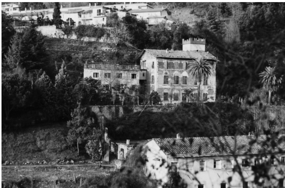
Tav. 20 - Massa, Villa della Concia prima dei restauri.
