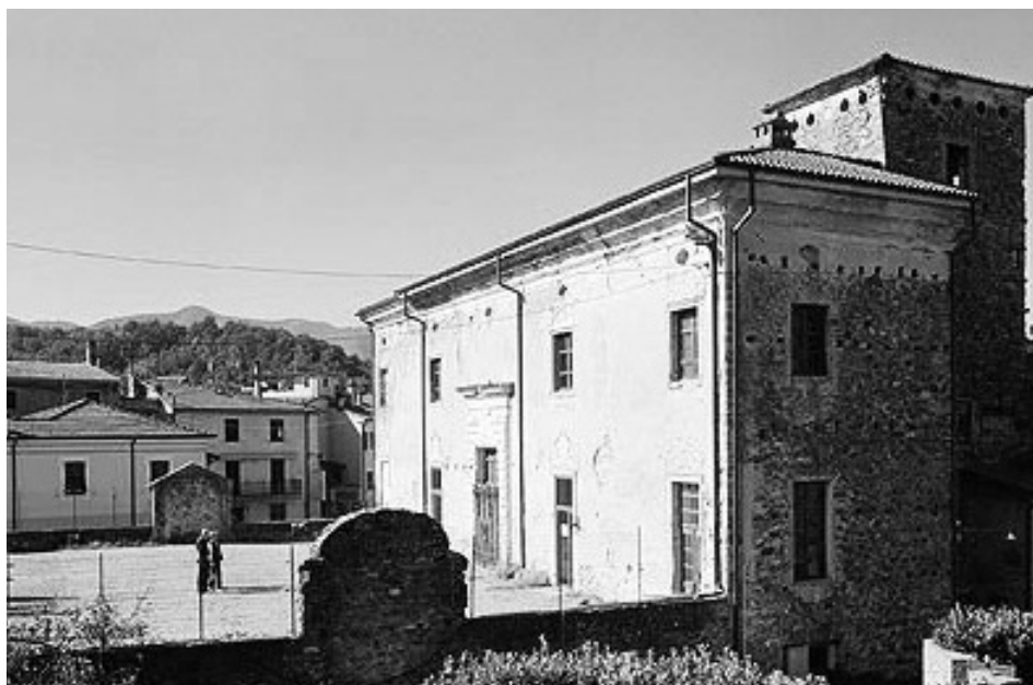
Tav. 13 - Pallerone, il giardino pensile e la facciata principale del palazzo (foto di Andrea Botto).
