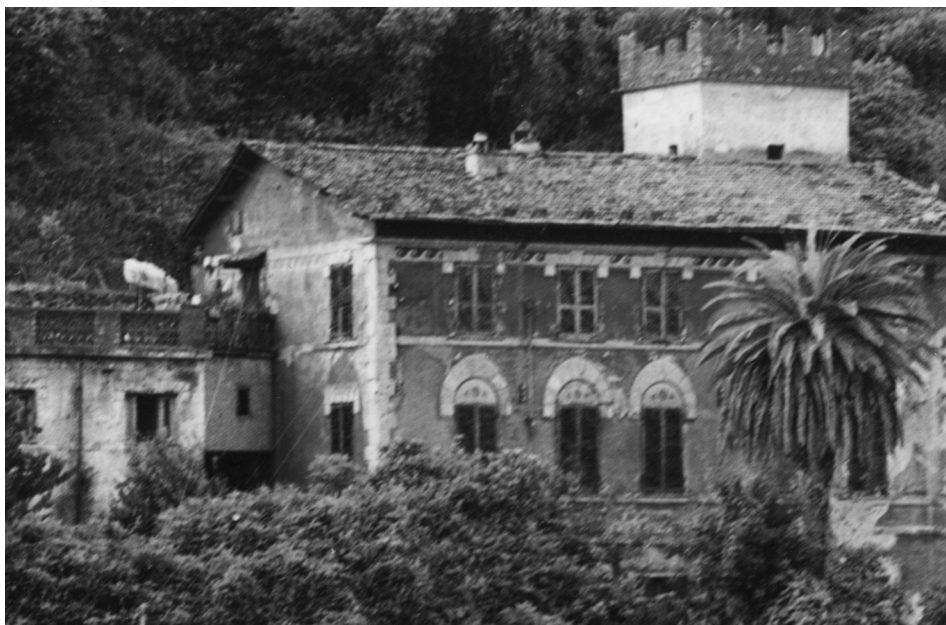
Tav. 21 - Massa, Villa della Concia, dettaglio della facciata.
