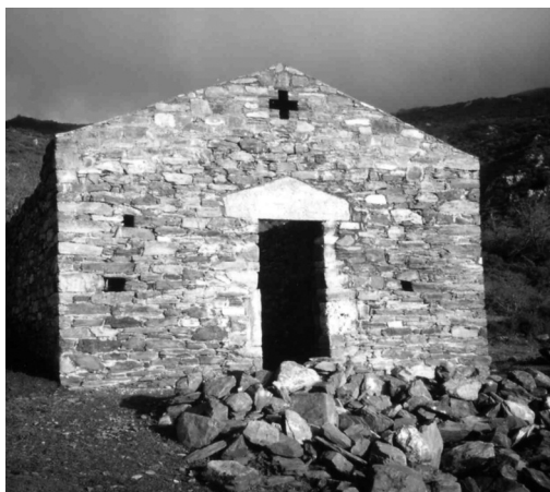
Fig. 6 – S. Quilico, à Bisinchi: la façade occidentale après les travaux de consolidation menés par la FAGEC.
