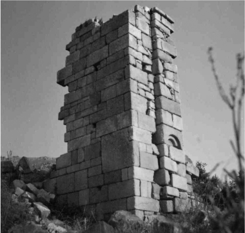
Fig. 2 – S. Nicolao di Spano, à Lumio: archivolte romane réemployée dans un pilastre édifié tardivement près de l'angle nord-ouest.
