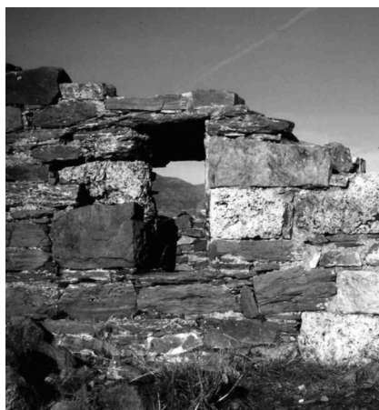
Fig. 7 – S. Quilico, à Bisinchi: l'abside et l'angle sud-ouest après les travaux de consolidation menés par la FAGEC.
