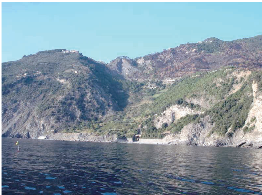
Foto n. 25 – La frana di Guvano, in corrispondenza della sella l'abitato di San Bernardino
