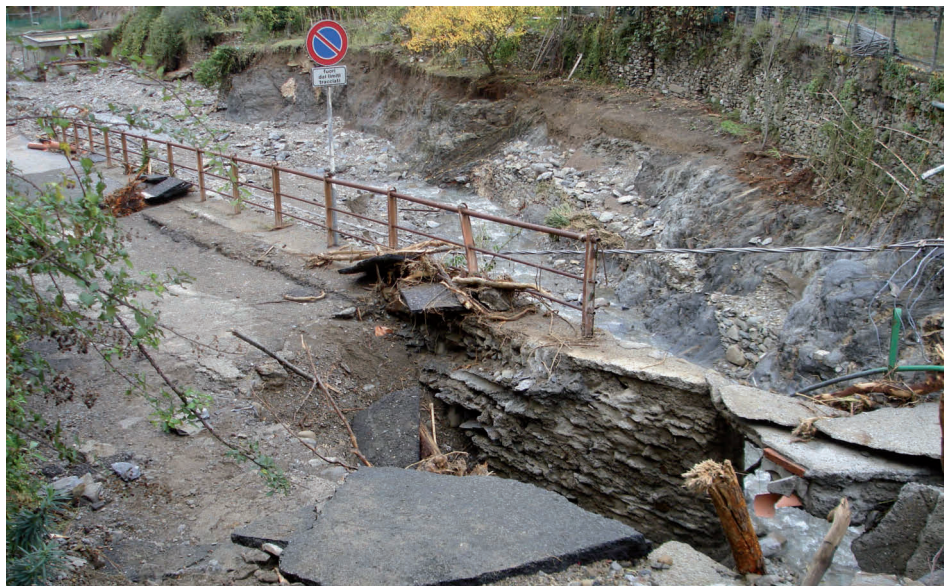
Figura 5: un aspetto del Canale di Vernazza a monte dell'abitato
