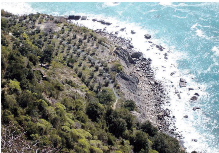
Foto n. 26 – L'azione del moto ondoso sul fronte della frana di Guvano
