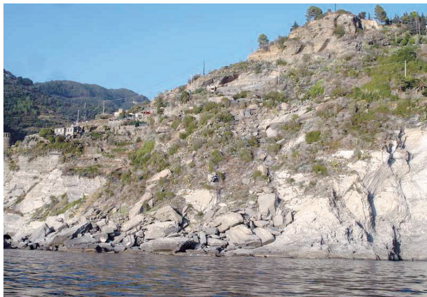
Foto n. 28 – Frana di scivolamento degli strati di arenaria a franapoggio presso Vernazza
