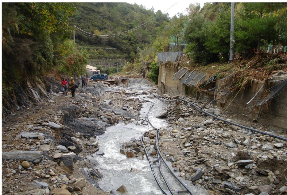
Fig. 26 - L'erosione del canale di Vernazza a seguito della piena del 25 ottobre 2011
