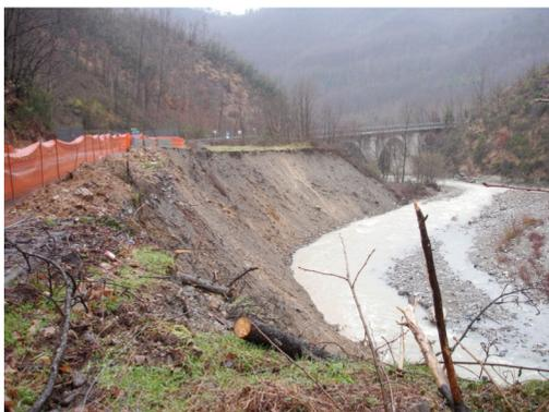
*bivio per Mangia, in prossimità della Sp 566, erosione spondale del Torrente Mangia*
