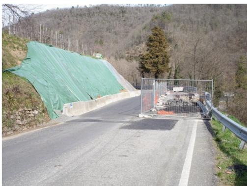
*strada Aurelia, c/o Boccapignone, crollo del muro sottoscarpa ed esecuzione di scavo a monte per ampliare l'unica corsia di transito. Testimoni le acque del Fiume Vara hanno sopravanzato la base del muro per cui è plausibile identificare nello scalzamento a valle la causa principale del crollo*
